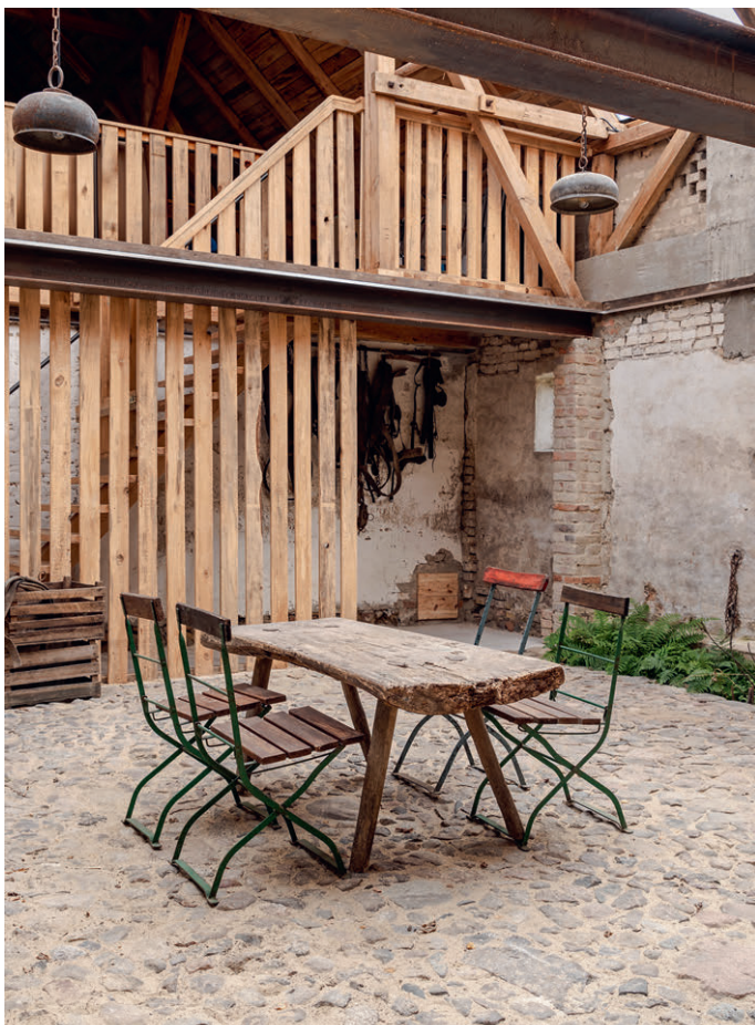
Stahlträger ermöglichen die neue Nutzung der Scheune, während das alte Mauerwerk erhalten blieb. Die alten Obstkisten und der Tisch mit Gebrausspuren passen perfekt.
