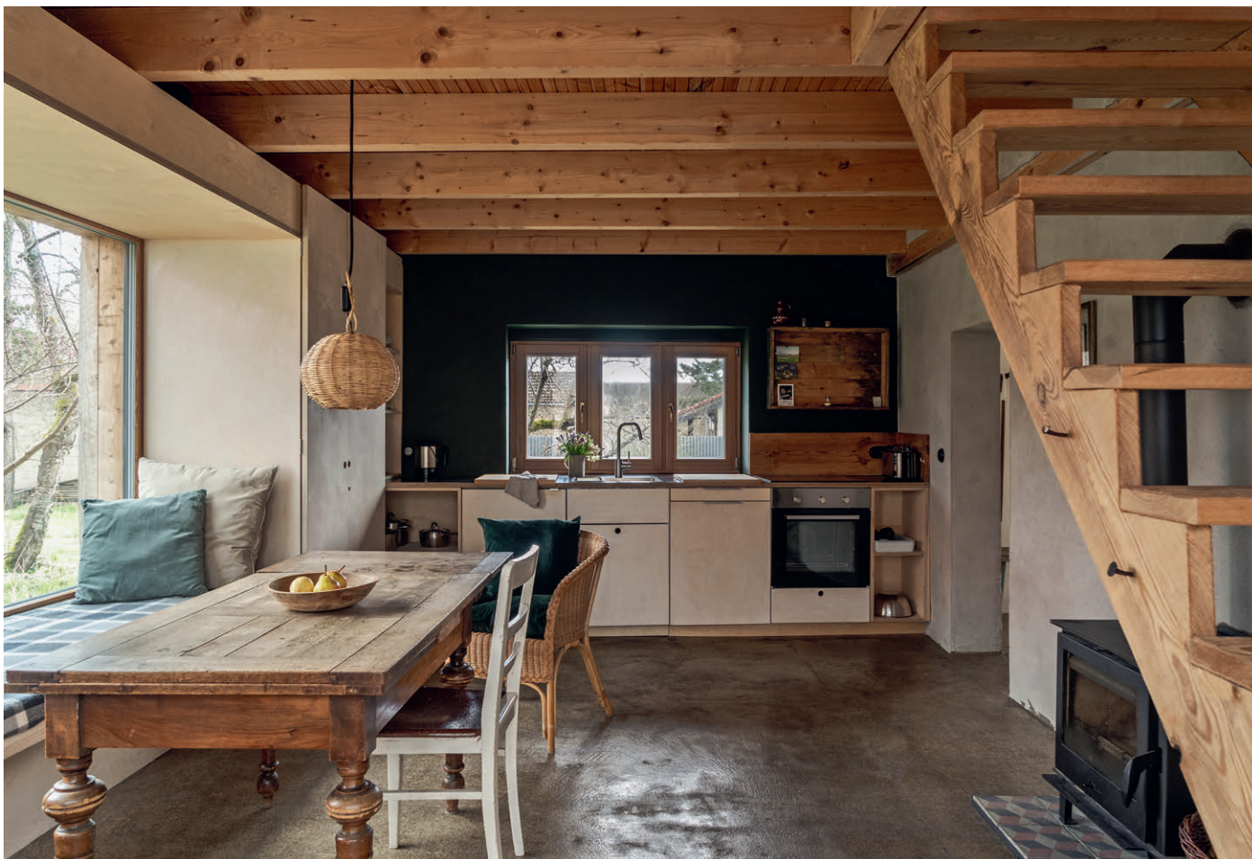
Sichtbare Balken, Lehmputz und moderne Haustechnik bilden eine bewusste Balance zwischen Vergangenheit und Gegenwart.
