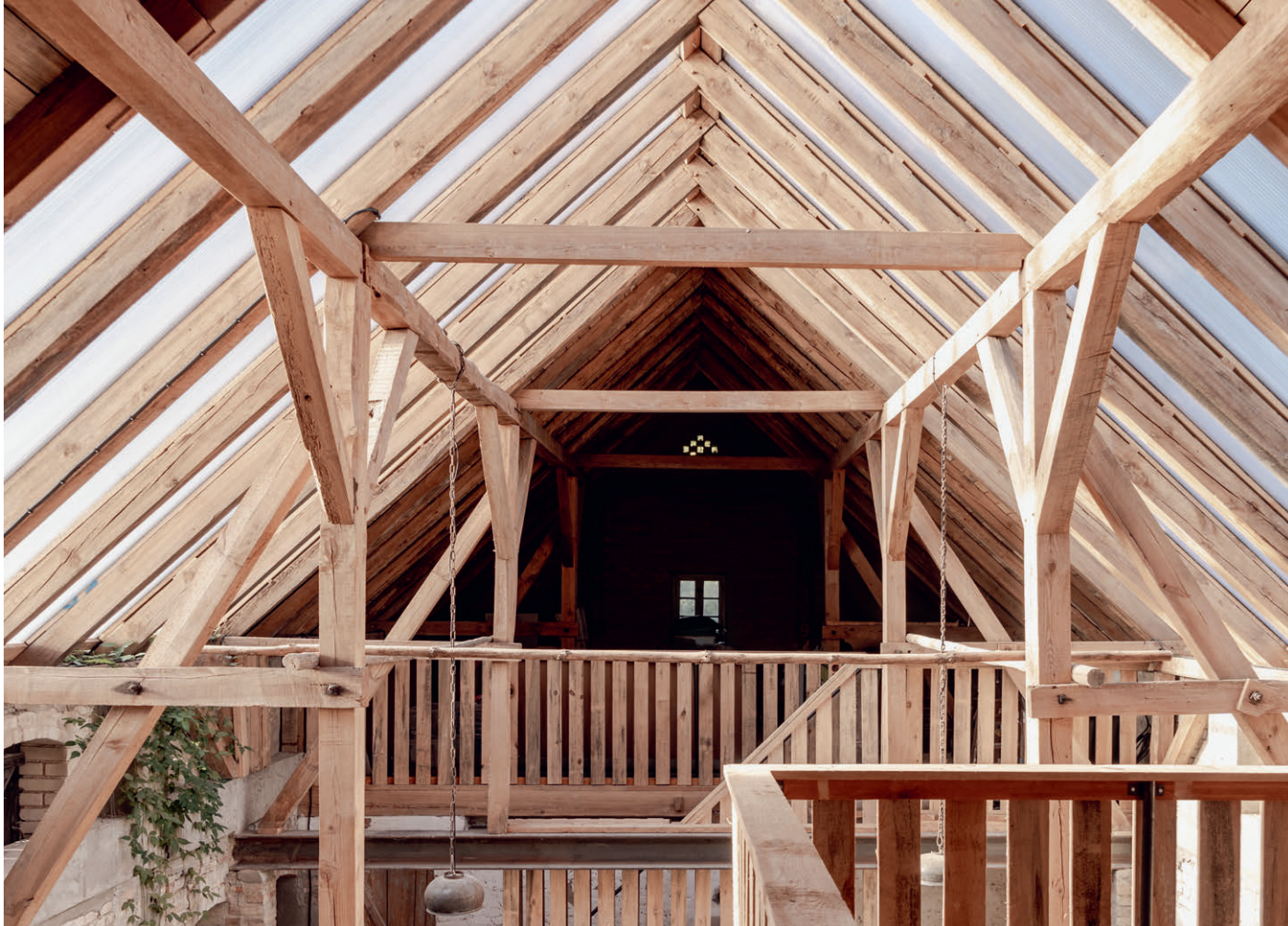
Das freigelegte Dachtragwerk veranschaulicht die Dimension der ehemaligen Scheune. Der Umbau macht die ursprüngliche Konstruktion weiterhin ablesbar.
